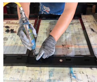
Install glass door
