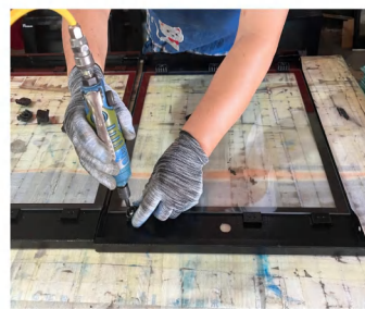
Install glass door
